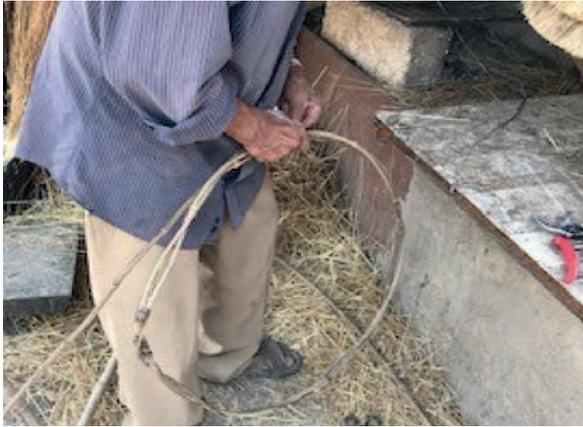
Una vez asegurada el constructor comienza a enrollar otro tramo de Temecate, enroscando este sobre el tramo existente a manera de espiral, para comenzar a formar un solo cuerpo compuesto por varias lianas de Temecate, siempre traslapando cada nuevo elemento, al menos una cuarta con un atado de hilo de maguey Figura 15.
