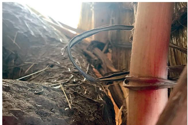
Con el hilo aprisionando tanto al interior como al exterior la vara de temecate, se realiza un nudo para fijar la capa de zacate que ya se ha superpuesto sobre la primera. Figura 24.
