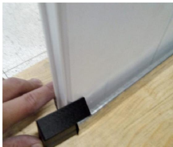
*Nota:* La figura muestra el diseño de calza que se elaboró en la impresora 3D para evitar el movimiento de los paneles de PVC sobre el canal de lámina galvanizada.
